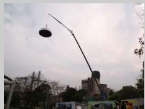
以 110 噸重型吊臂安裝圓頂。
